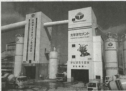
札幌工場ではハイスペックな配合の生コンを出荷している
